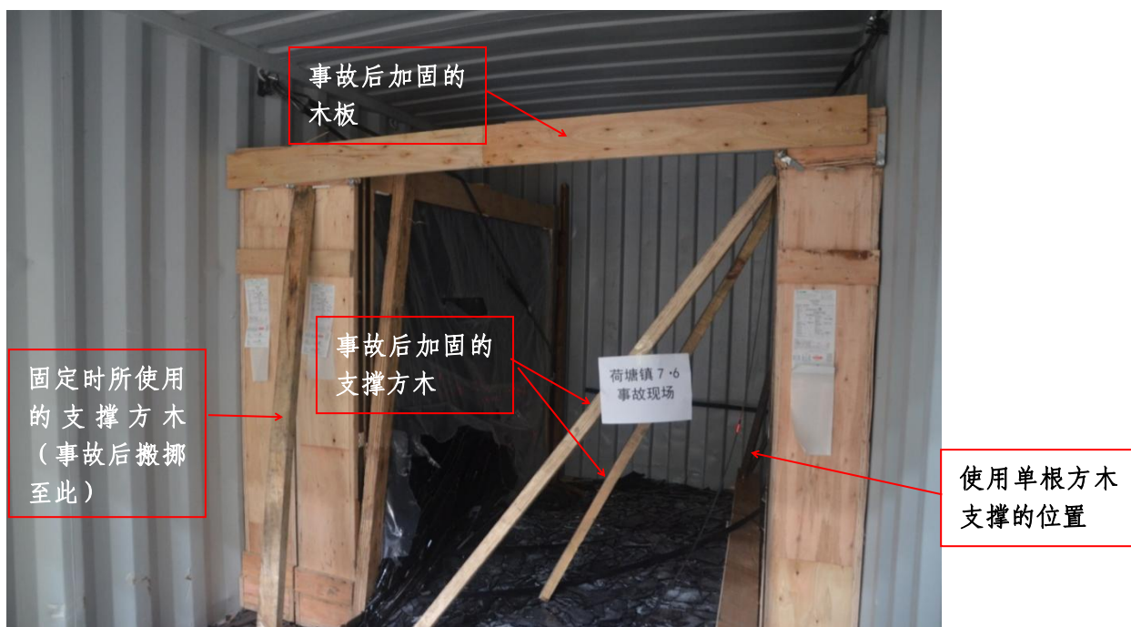
图 6 事故现场 (货车车厢内部)
